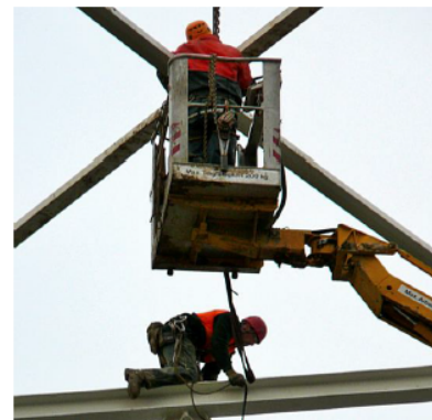
2: Alternative zu Bild 1: Zugang mittels Hubarbeitsbühne
